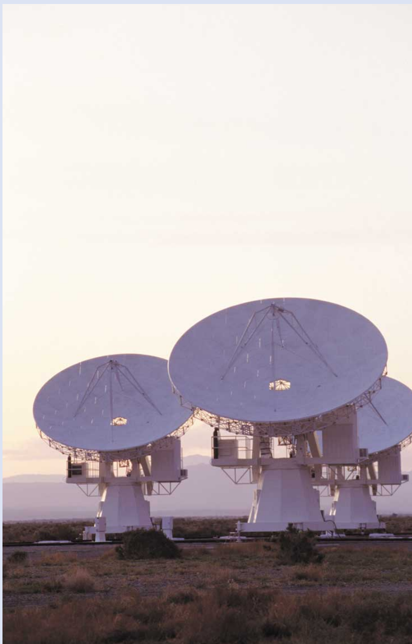
Antennes de station terrienne de faisceaux hertziens
